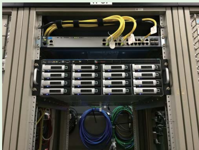
<リニア編集室奥に設置されたEditShare XStreamHT 48TB. 今後の仕様要求に合わせて拡張を予定>
